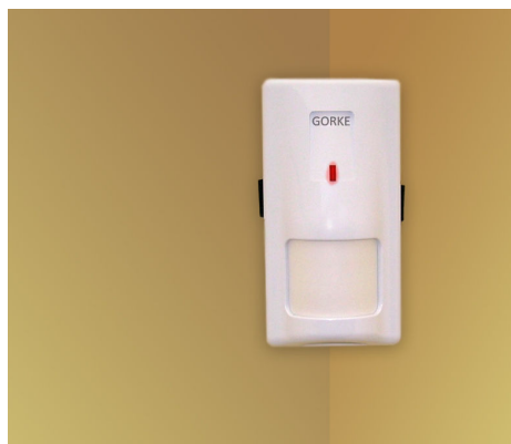
Rysunek 15. Zamocowanie czujki w narożniku chronionego pomieszczenia
